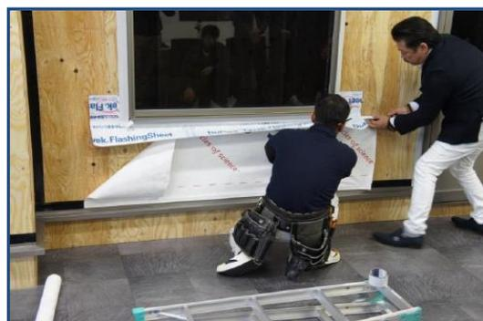
模擬棟を使い、防水紙の施工手順や施工のポイントを実際に目でみて、体験することができます。
